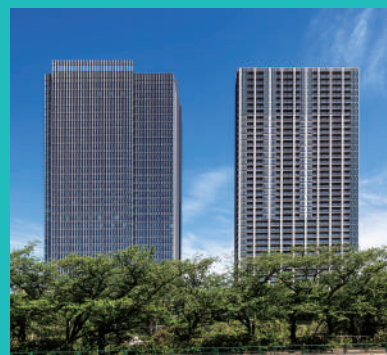
飯田橋駅西口地区市街地再開発(住宅棟) (梁)
