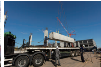
現場へのPCa部材納品の様子
