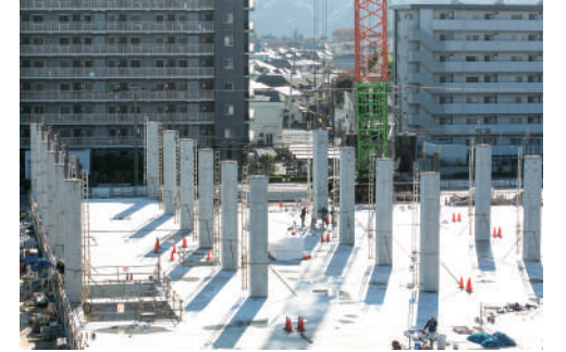
大型の柱部材を製造・納品した物流倉庫の現場の様子
