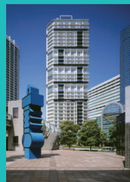
パークタワー横濱ポートサイド (柱・梁、他)
