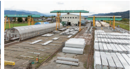
地方ならではの広いストックヤードを生かし、現場の計画変更にも柔軟な対応が可能
