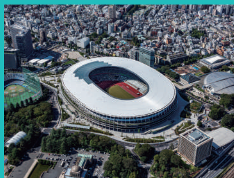
国立競技場(PCa部材納品) 提供:大成建設株式会社
