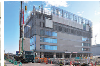
カーテンウォールPCaの取り付けの様子
