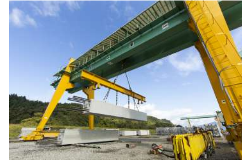
30tや20tの門型クレーンや、50tのクローラークレーンを配置することにより、大型で重量のあるPCa部材の製造が可能 ※写真は30t門型クレーン
