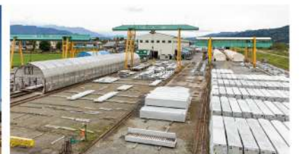
地方ならではの広いストックヤードを生かし、 現場の計画変更にも柔軟な対応が可能
