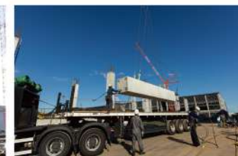
現場へのPCa部材納品の様子
